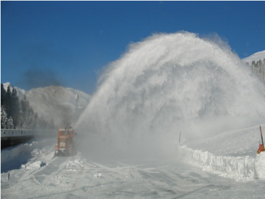
Schneeräumung an der Flüela Passstrasse auf rund 1800 m, Davos, GR (Foto: SLF/L. Stoffel, 16.11.2007).
