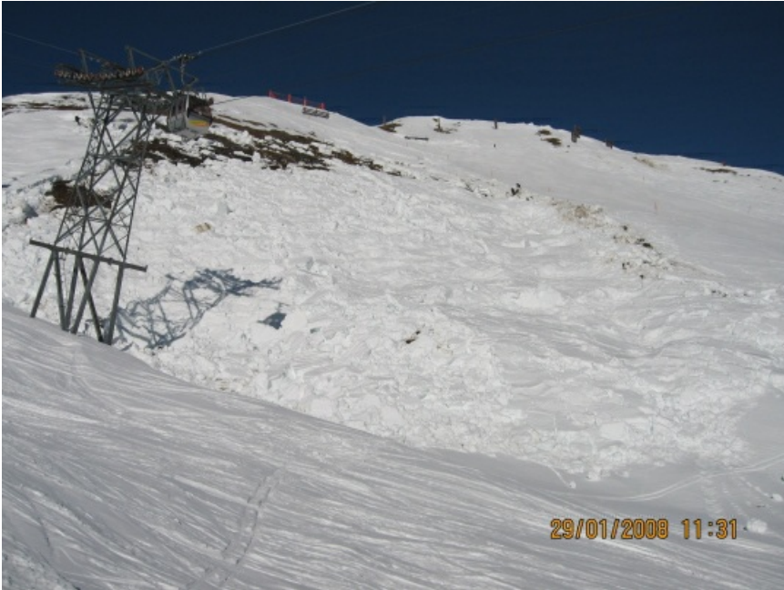
Gleitschneerutsche auch in Grindelwald, BE. Dank der geringmächtigen Schneedecke wurde der Masten der Firstbahn nicht gefährdet (Photo: A. Heim, 29.01.2008).
