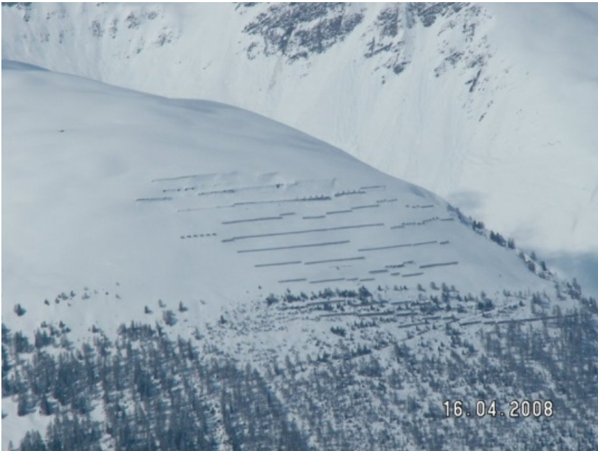
Die Lawinverbauungen haben in diesem Winter viel zu tun. An diesem Südwesthang auf rund 2200 m oberhalb von Obergesteln, VS sind die obersten Werksreihen eingeschneit (Foto: SLF/Th. Stucki, 16.04.2008).
