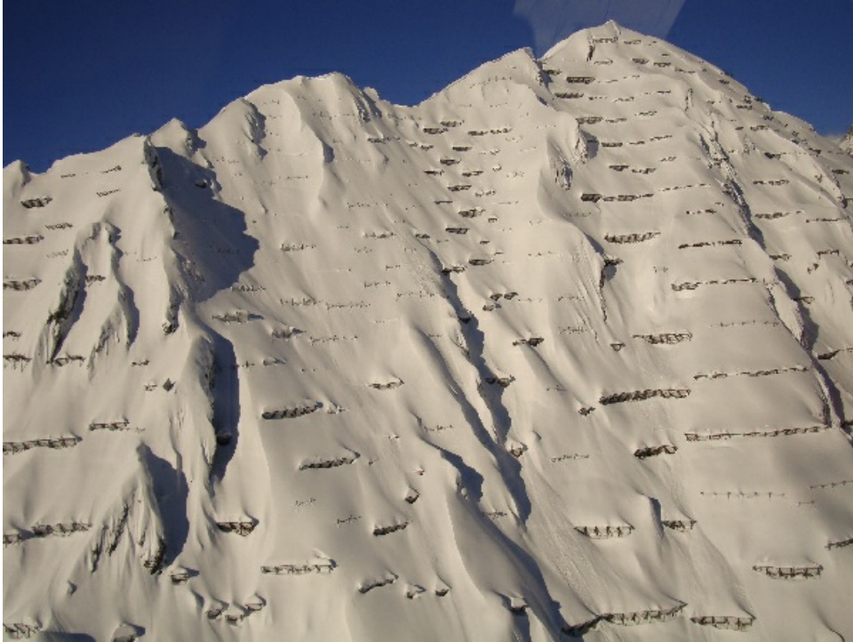
Abb. 1: Noch ist Platz in den Lawinenverbauungen oberhalb von Gurnellen (UR). Stützverbauungen in Form von Schneebrücken aus Stahl und Schneenetzen, wie hier im Bild am Geissberg (am Witenstock, 2392 m), verhindern das Anbrechen von Lawinen und stabilisieren die Schneedecke. Die Höhe solcher Stützverbauungen ist regional unterschiedlich. Sie hängt von den zu erwartenden extremen Schneehöhen im Anrissgebiet ab. Bei den zu erwartenden extremen Schneehöhen wird von einem einhundertjährigem Ereignis ausgegangen. In der Verbauung Geissberg beträgt die wirksame Rosthöhe je nach Standort 3.5 oder 4.0 m. Damit kann eine lotrechte Schneehöhe von rund 4.5 bis 5.0 m abgestützt werden (Foto: H. M. Henny, 10.01.2012). Weitere Informationen zu Lawinenschutzmassnahmen finden Sie hier.
