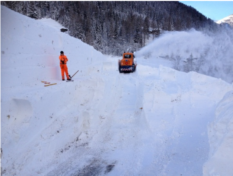
Räumungsarbeiten auf der verschütteten Strasse zwischen Binn und Fäld (VS, 1470 m). Die Lawine Tielöuwigraben ist in der Nacht vom Donnerstag, 05.01. auf den Freitag, 06.01. abgegangen. Breite ca. 120 m, maximale Ablagerungshöhe ca. 6 m (Foto: H. Gorsatt).
