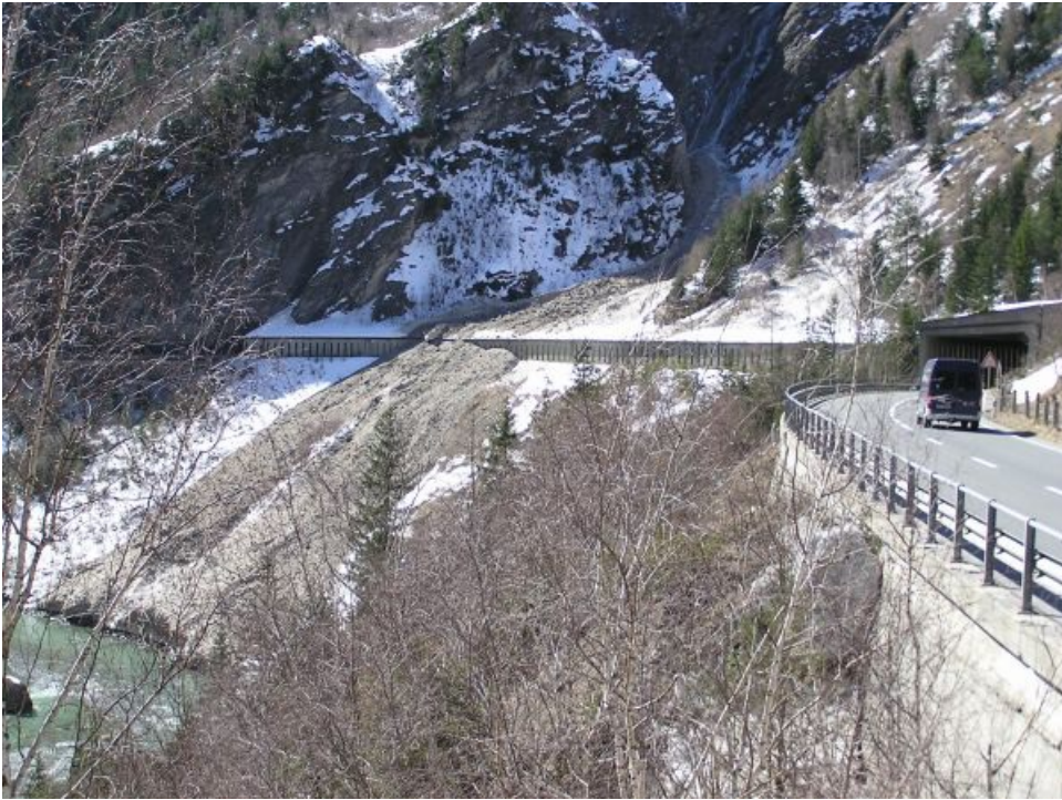
Lawinkegel im Val Mundin, nördlich von Martina, GR kurz vor der Grenze zu Österreich. Die Galerie hat ihren Zweck erfüllt (Foto: SLF/C. Pielmeier, 16.03.2012).
