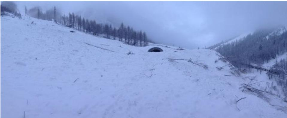
*Abb. 7: In der Nacht zum Dienstag, 04.03. ging eine grosse Lawine am Täschwang spontan ab und überführte die Zufahrtsstrasse zu Zermatt, die Vispa und das Bahntrasse der Matterhorn-Gotthardbahn. Zu sehen ist das verschüttete Nordportal des Strassentunnels. Die Lawine zerstörte auch einen Teil des Waldes im Bereich des Lawinenzuges (Foto: H. Lauber).*
