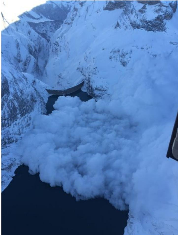
Abb. 1: Lawinensprengung an einem sehr steilen Westhang zur Sicherung der Baustelle Linth-Limmeren (Linthal, GL). Der Bruch erfolgte auf über 200 m Breite in den tiefen Altschneesichten. Grössenvergleich: Der Wasserspiegel liegt 40 m unter der Mauerkrone (Foto: R. Stüssi, 18.01.2016).
